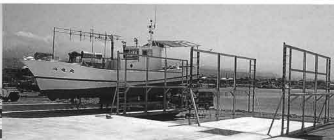
水道とトイレが用意された管理事務所と船揚組合の上下架用スロープ
