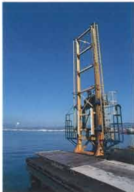
エレベーター式の揚降施設は、関東の大規模マリーナを参考に採用したとのこと。省力化にも貢献
