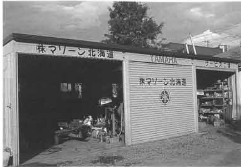
(株)マリン北海道のサービス工場。これも春までの仮施設となります
