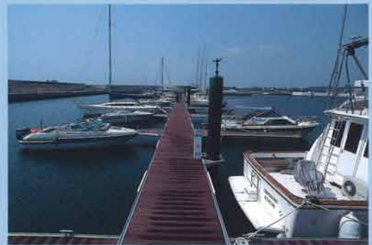
ポンツーンは計4本の建設が予定されており、126隻の海上係留が可能となる。給電給水施設も完備
