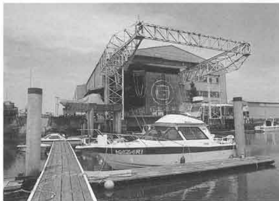
大型クレーンと、その奥にひかえる屋根付きの艇庫。恵まれた施設と広さがセーラーズさんの自慢です
