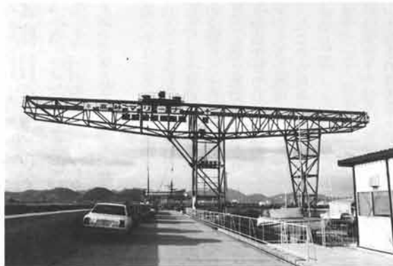
●兵庫県高砂市「高砂マリーナ」 ①ガントリークレーン②四国建機株③12トン
