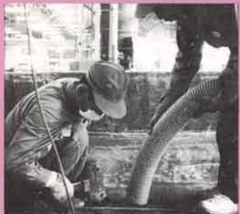
⑤樹脂が固まったら、サンダーで仕上げをします。
