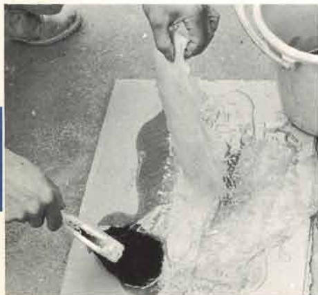
ガラス繊維にたっぷり樹脂をします 水気があると硬化しませんガラス繊維 の保管も湿気を防いでください
