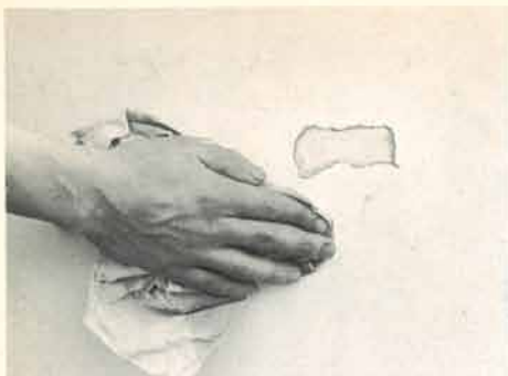
補修する部分のまわりをペーパーでみがきアセトンで拭き穴をきれいに整理します
