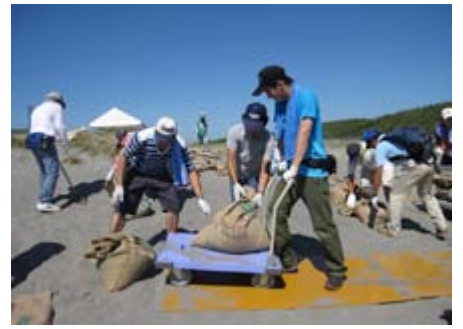
土のう積み作業
