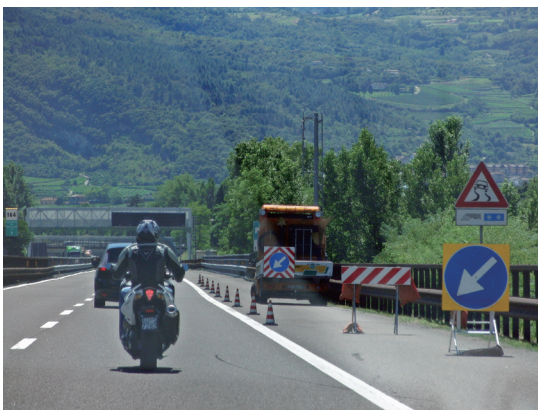
図6 道路工事通過の様子
